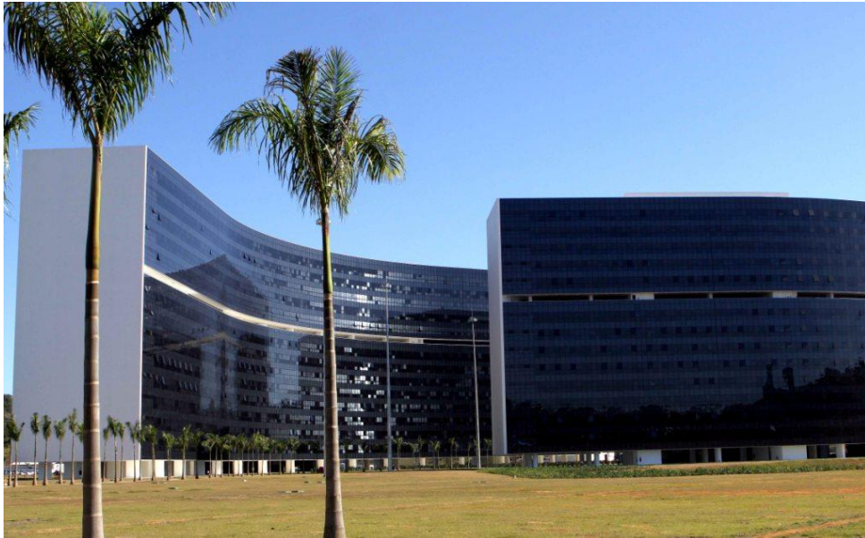
FIGURA 2 – Foto parcial da Cidade Administrativa Presidente Tancredo Neves.
